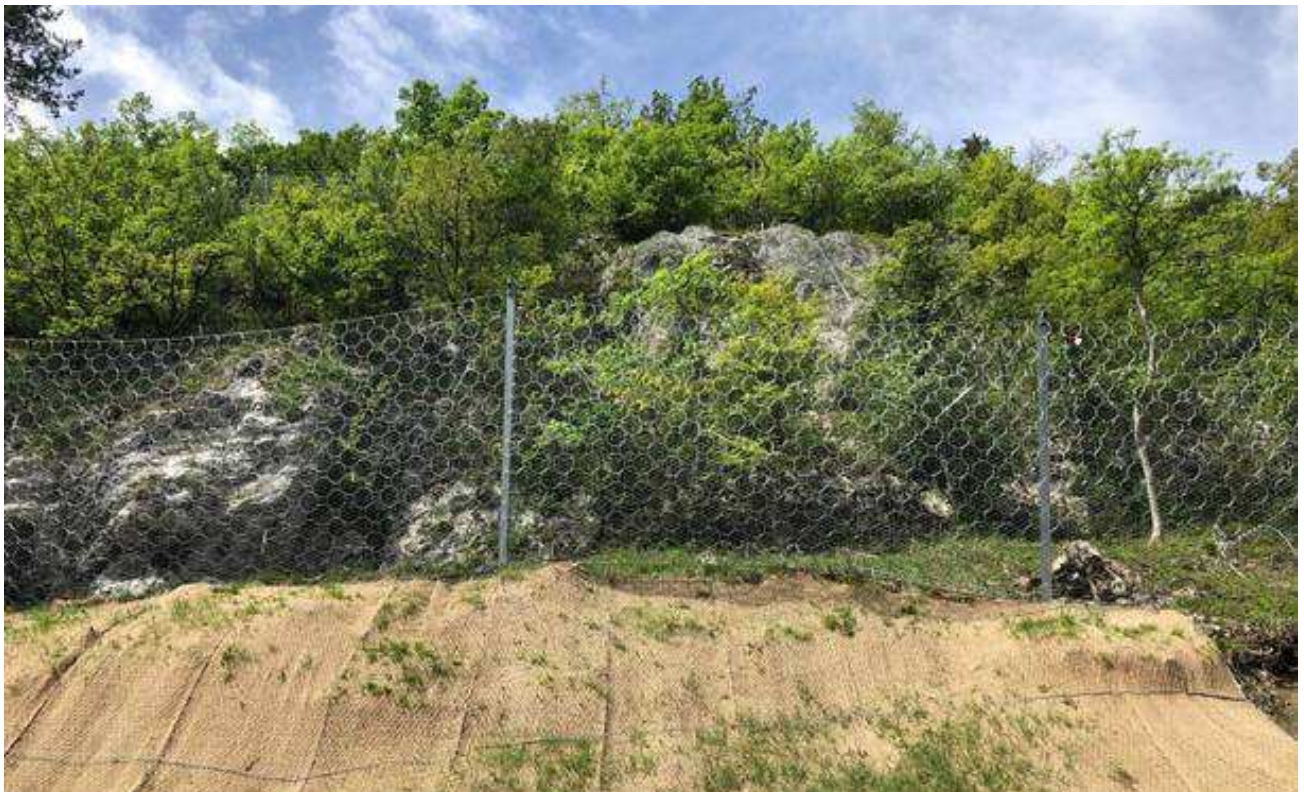
Foto 7 - Barriere paramassi (2018).
